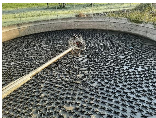
Flexible Abdeckung mit Schwimmkörpern zur Emissionsreduktion
