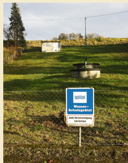
Bild 1: Der Schutz von Wasserversorgungsanlagen hat oberste Priorität.
